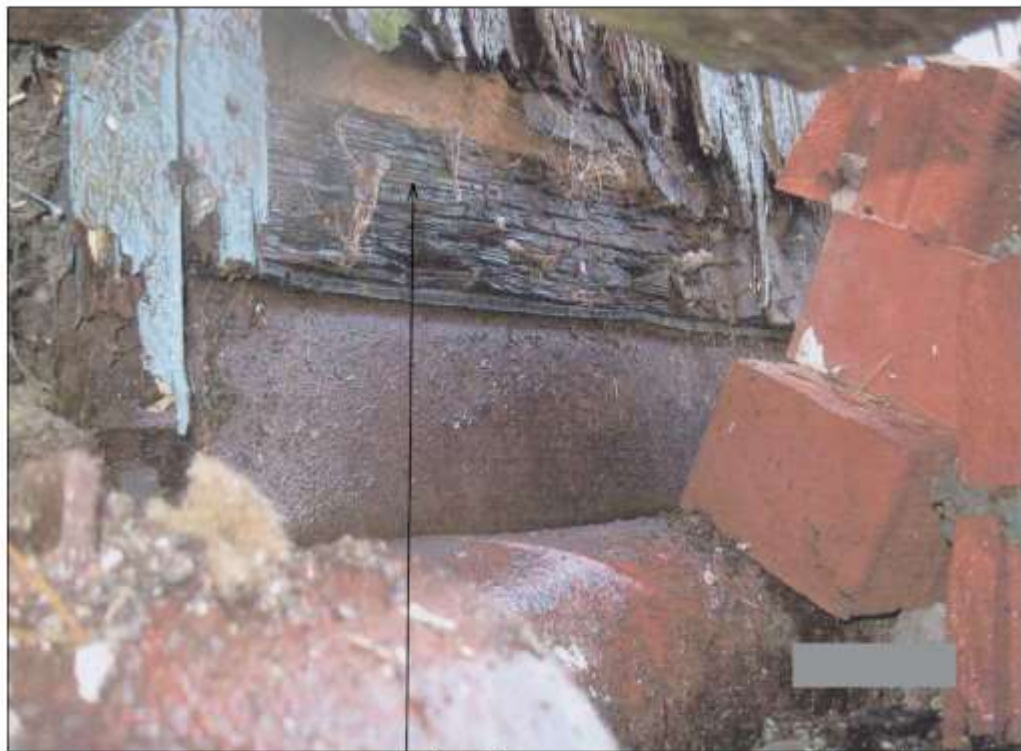
Фотография 2.16. Фрагмент цоколя и примыкания блок-комнат к обвязке из труб
