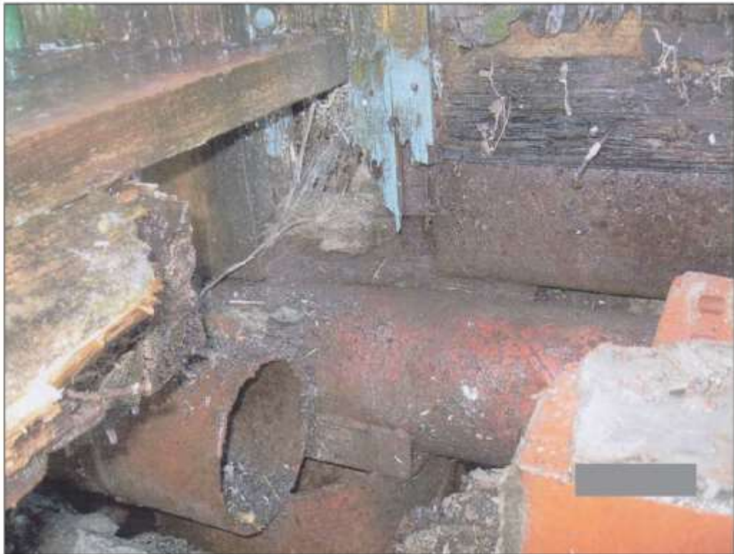
Фотография 2.15. Фрагмент обвязки фундаментов. Низ блок-комнаты. Деревянные конструкции повреждены гнилью
