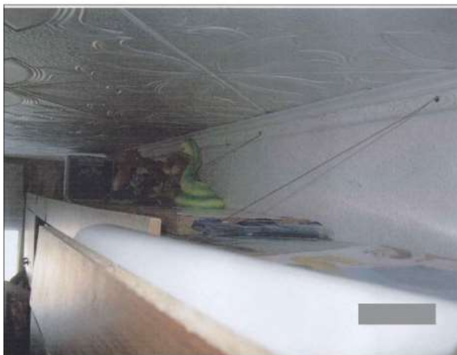
Фотография 2.18. Фрагмент потолка Отслоение потолочной плитки, следы протечки и плесени
